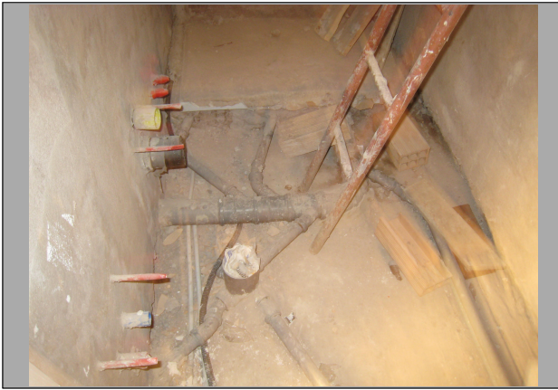
Ristrutturazione Appartamento ID 25 L'impianto con gli allacci idraulici
